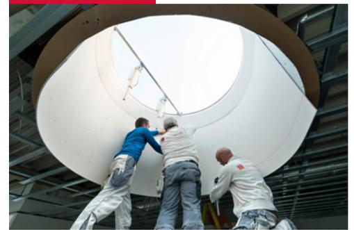
verspachtelte Decke in Q3 bildet dabei ein Pendant zum edlen, von Germerott verlegten Granitboden. In den restlichen Räumen kommen Rasterdecken mit Mineralfaserplatten zum Einsatz. Diese bieten einen direkten Zugang zu den Installationen in der Decke und sind ebenfalls akustisch wirksam.
